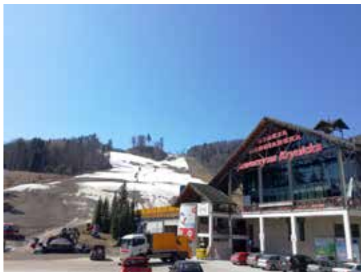
Fot. 4 Stacja dolna Jaworzyna Krynicka
